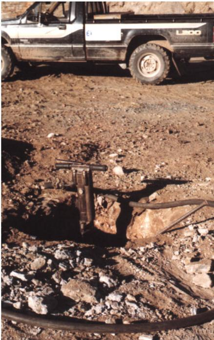
Foto 7.1 - Vista de excavación con taladro neumático para la fundación de una base de columna de alta tensión de línea de 220 KV.
