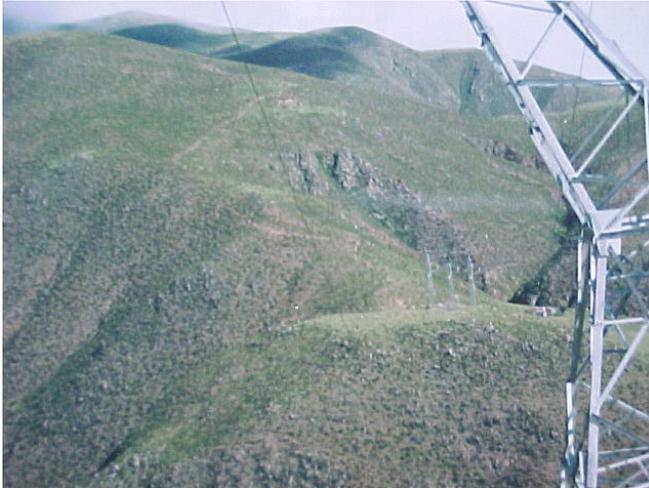
Foto 7.3 Vista de tendido eléctrico en área de alta topografía relativa, habiéndose utilizado helicóptero para transportar materiales y equipos para el montaje (sin construcción de caminos de acceso)
