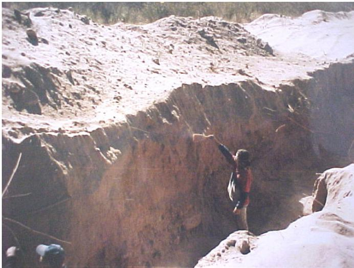
Foto 7.38 – Vista del control de perfiles artificiales por excavación de la zanja
