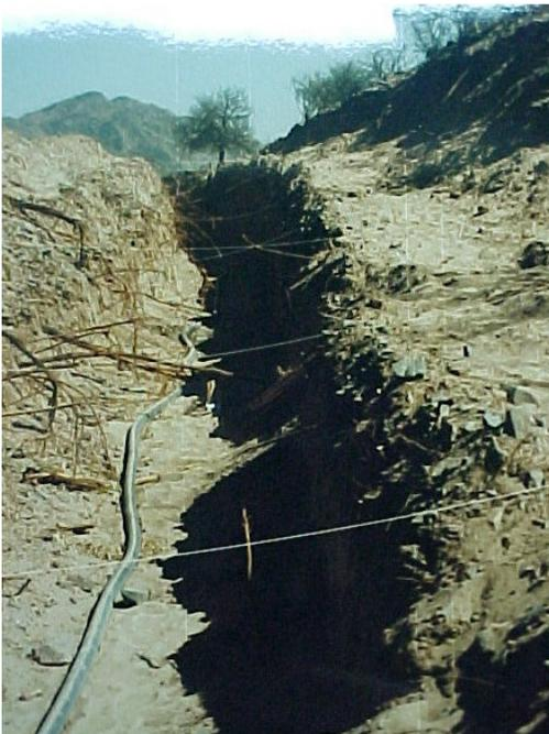
Foto 7.10 – Vista de zanja excavada para tender una manguera y suministrar de agua a un puesto de pastores. La acción bien intencionada provocó la afectación de evidencia arqueológica subsuperficial, realizándose actividades de rescate a posteriori.
