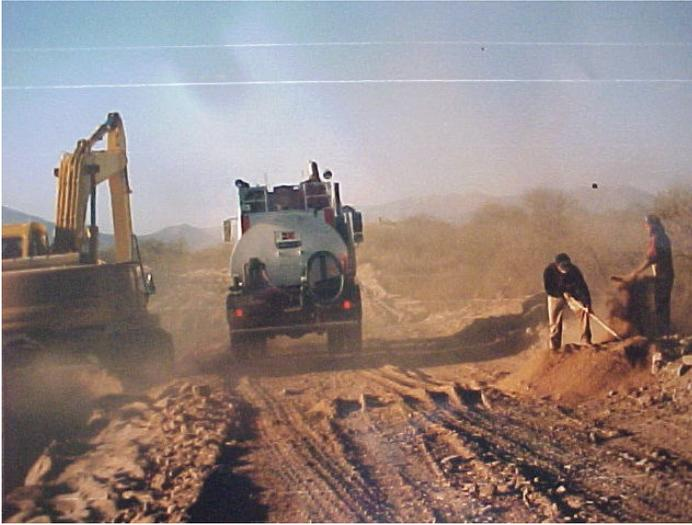
Foto 7.37 – Vista del tamizado de sedimentos por zaranda extraídos de la excavación de la zanja
