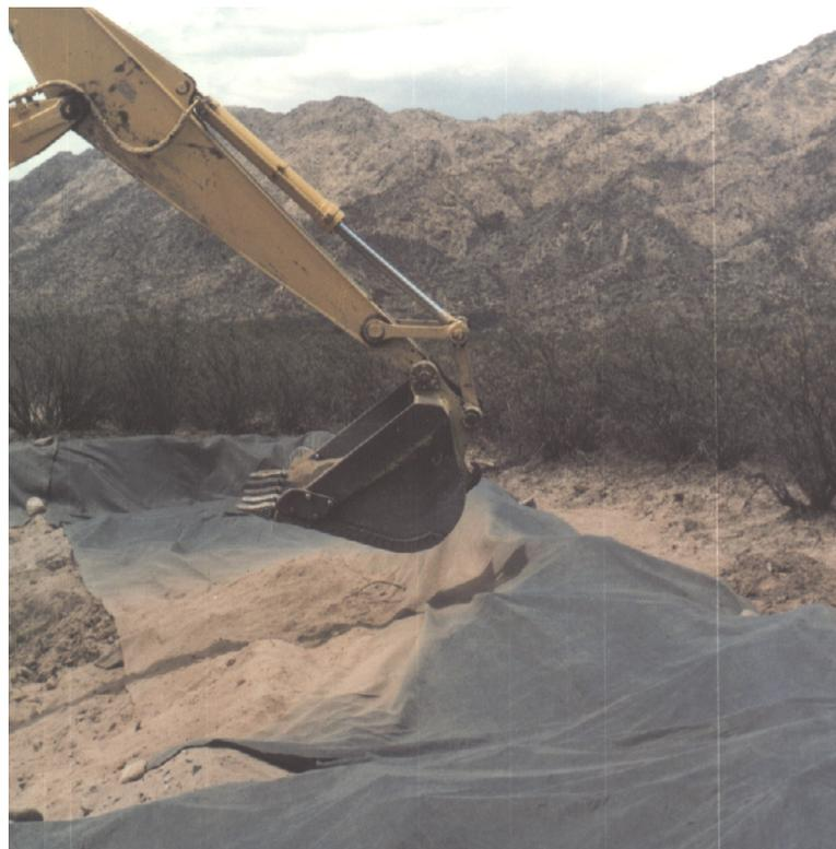
Foto 6.5 – Proceso de trabajos de conservación. Cubierta del sitio con geotextil para evitar su erosión por agentes naturales y depósito de material fino para cubrirlo y lograr *enmascararlo* (cf. Ratto 1997e).
