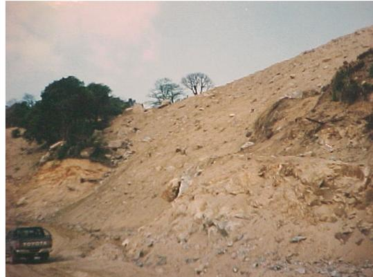
Foto 4.18 – Desplazamientos de suelo por ladera por nivelación y excavación para obra civil.
