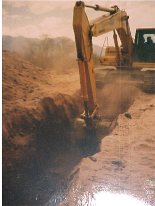
Foto 4.14 – Detalle de excavación de zanja con retroexcavadora (área de baja topografía relativa)
